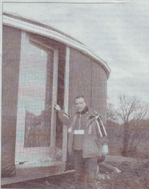
■ La yourte de François Maillet est équipée d'un chauffage solaire complété d'un puits canadien et d'un poêle à bois.
